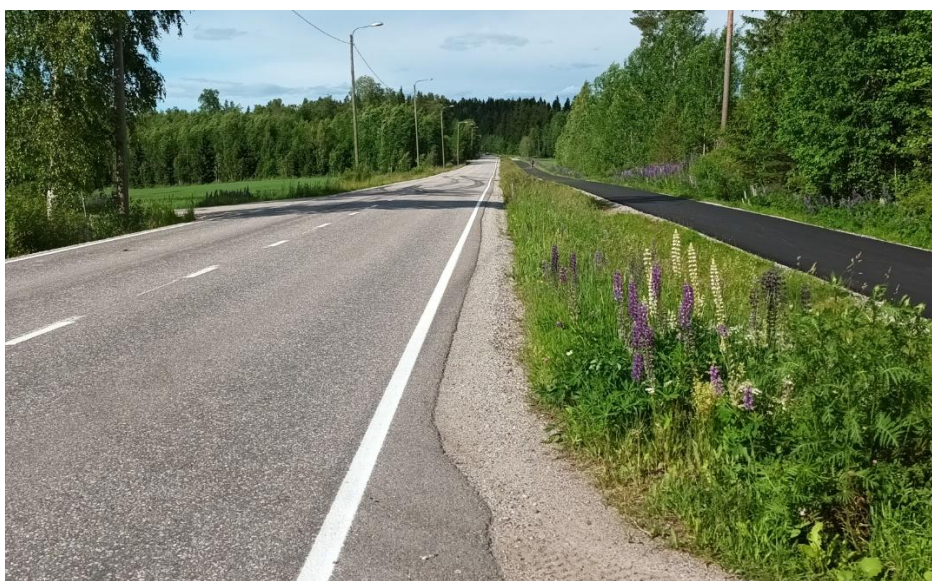
Kuva 7. Yleiskuva Nostavantieltä kohti koillista katsottuna. [Ramboll 23.6.2026]
