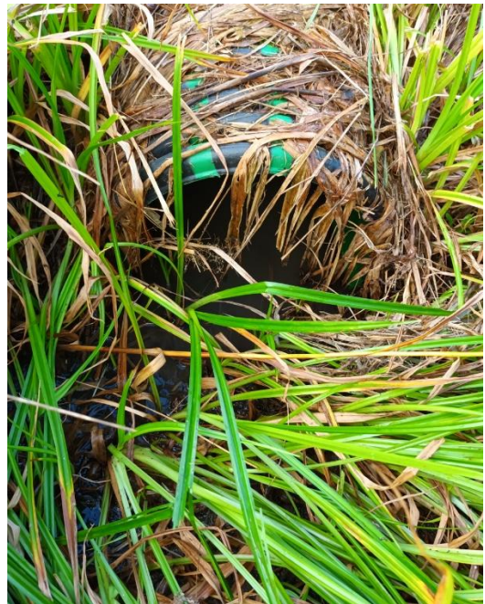
Kuvat 15. ja 16. Nykyinen Nostavantien alittava rumpu lähellä Vähäjoentien liittymää, joka johtaa Nostavantien eteläpuolelle kertyviä hulevesiä tien pohjoispuolelle. [Ramboll 17.9.2025]
