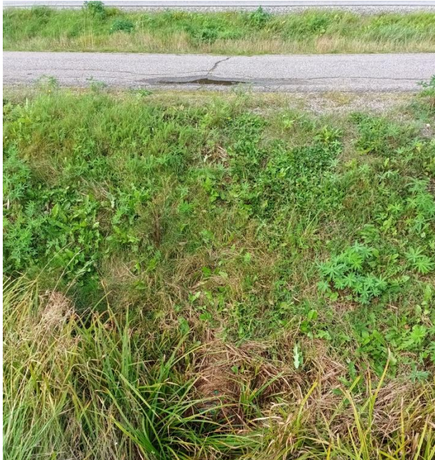
Kuvat 15. ja 16. Nykyinen Nostavantien alittava rumpu lähellä Vähäjoentien liittymää, joka johtaa Nostavantien eteläpuolelle kertyviä hulevesiä tien pohjoispuolelle. [Ramboll 17.9.2025]
